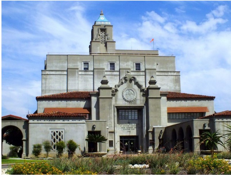
Planta de Tratamiento de Agua F.E. Weymouth de Metropolitan
